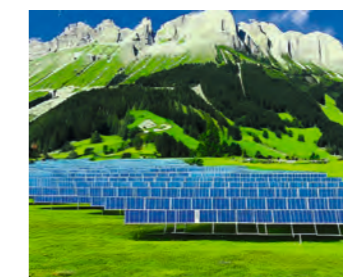
Moderne Solaranlagen können so gestaltet werden, dass sie auch in die Landschaft der Alpen passen.
